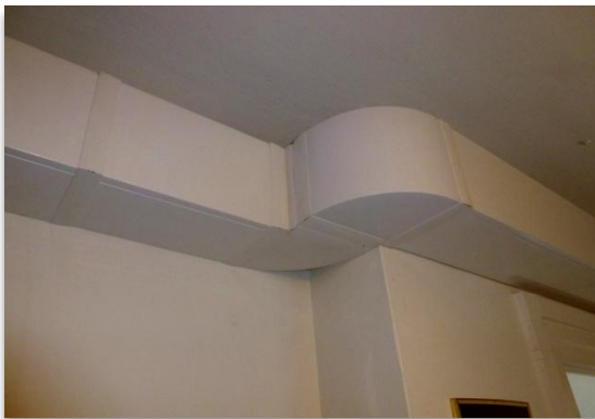
Le nouveau chemisage des conduits de ventilation
